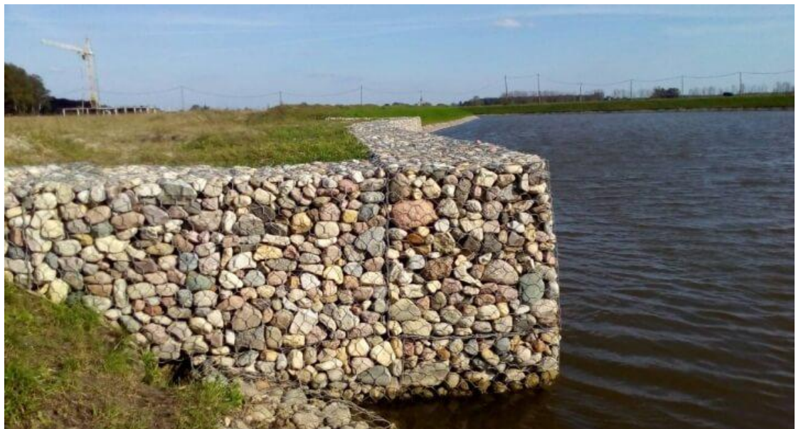
Рис. 1.4 – Габіон, заповненим природними каменем
