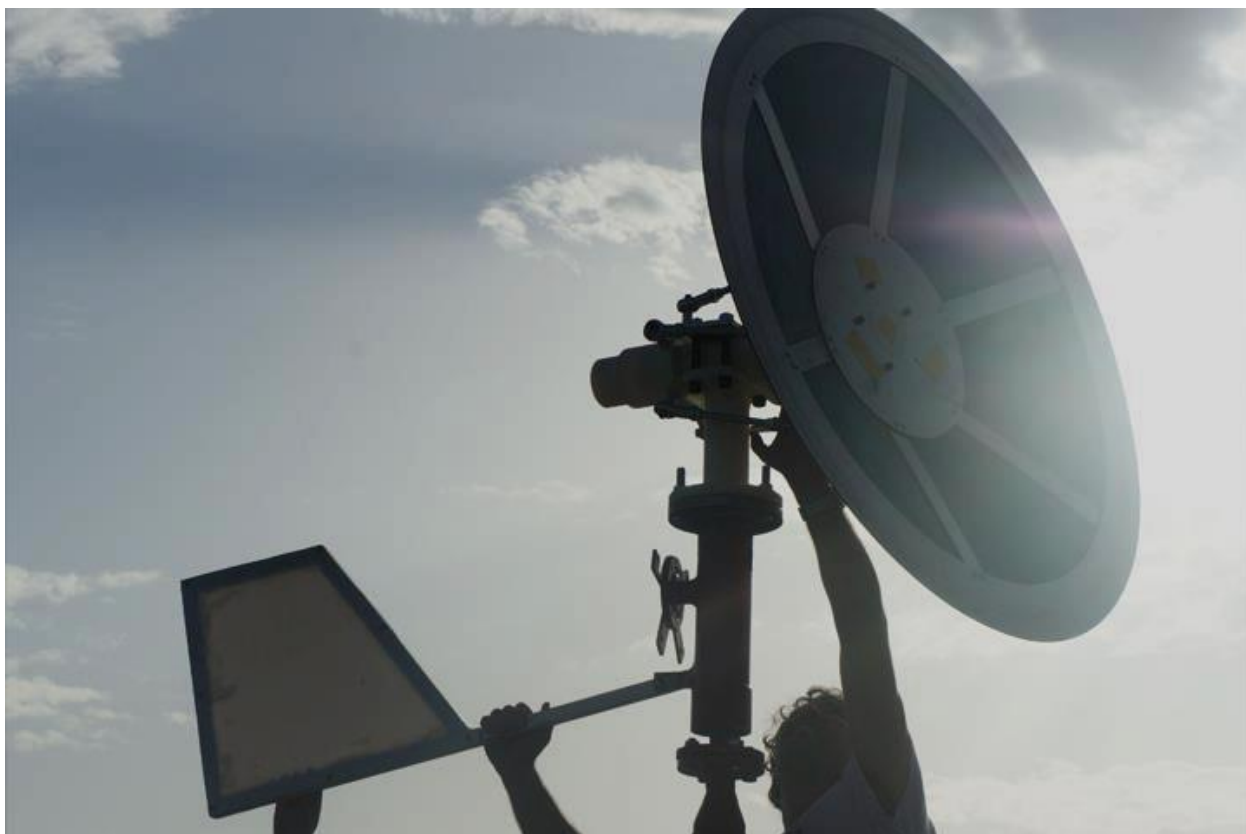
Рисунок 1.8 – Закріплення вітроустановки парусного типу Saphonian.
